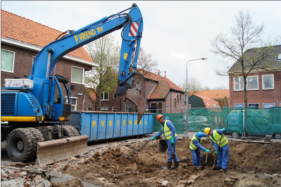
Afb. 48 De opgraving op de hoek van de Westerstraat en de Davidstraat in volle gang
